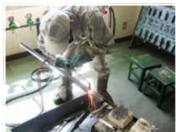
溶接(ガス切断)
