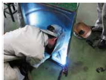
溶接(アーク溶接)
