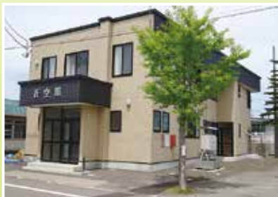
生徒会館「蒼空館」
